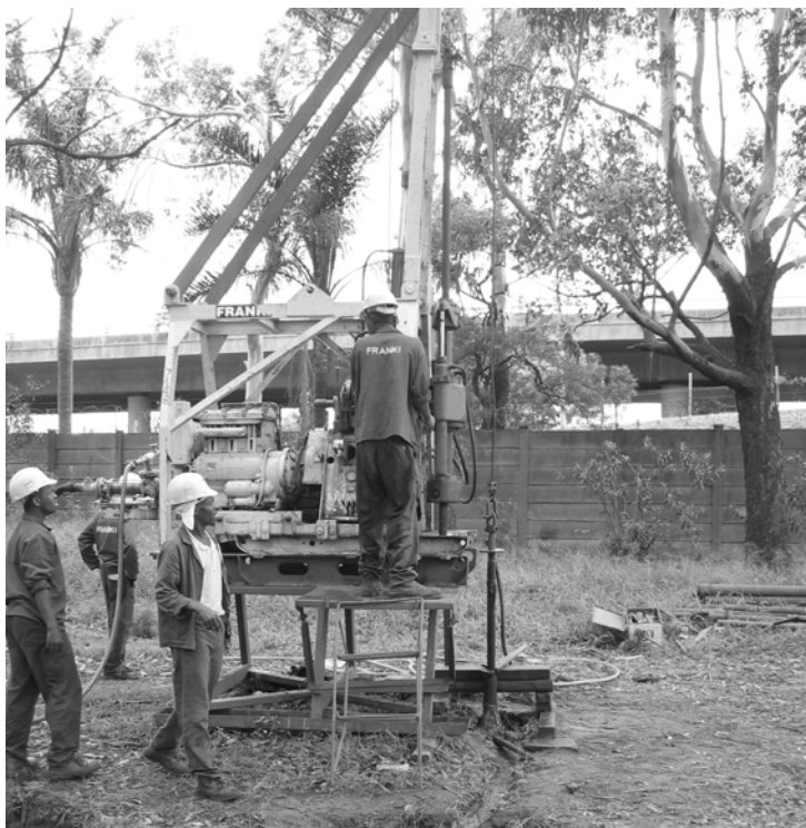
Bohrungen ergaben Verseuchung des Grundwassers rund um das BAYER-Werk
