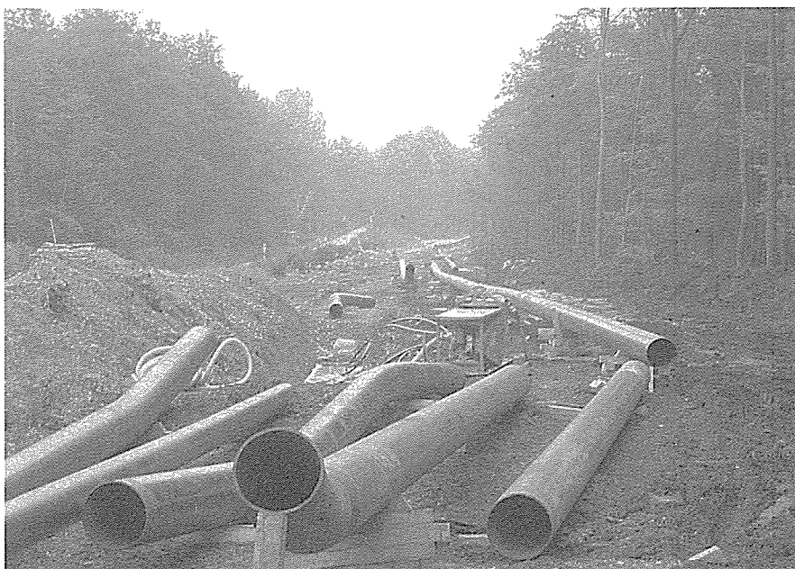
Die Pipeline-Verlegungsarbeiten
