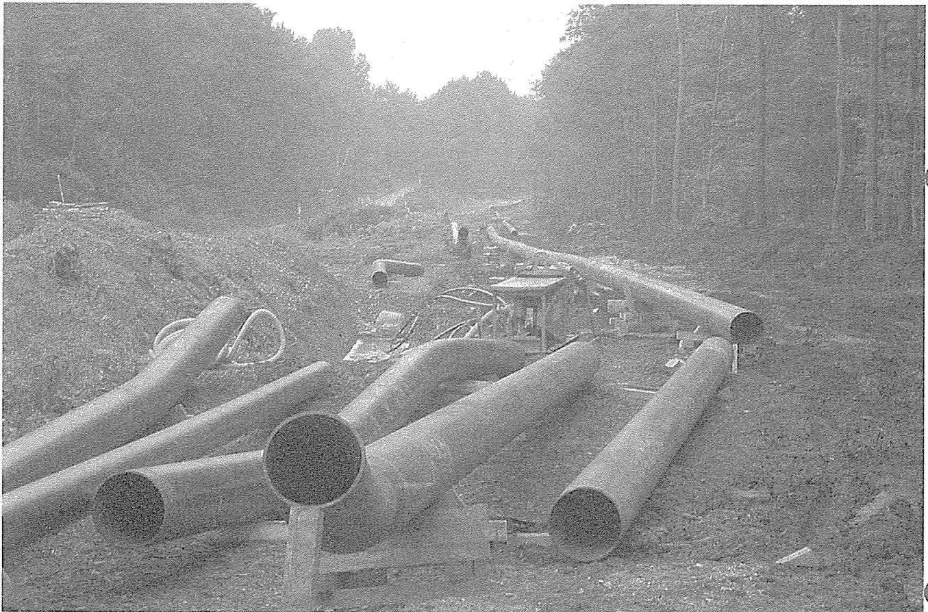
Die Verlegung der Kohlenmonoxid-Pipeline
