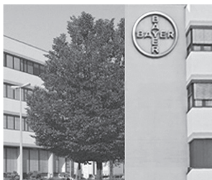
BAYER-Gebäude in Grenzach.
