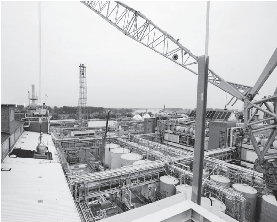
Die „Dream Production“ im Bau.
